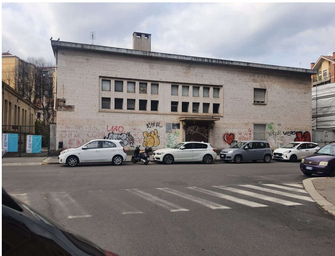
Fotografia 01 – STATO DI FATTO –fronte via Roccavione 11
